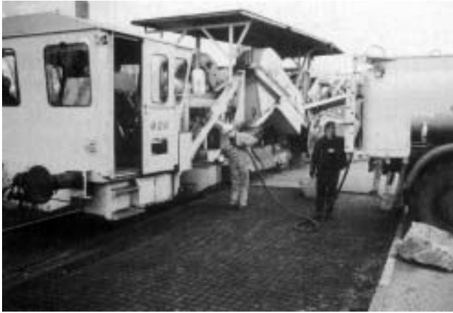
Bild 6: Användning av absorberande mattor på större yta
