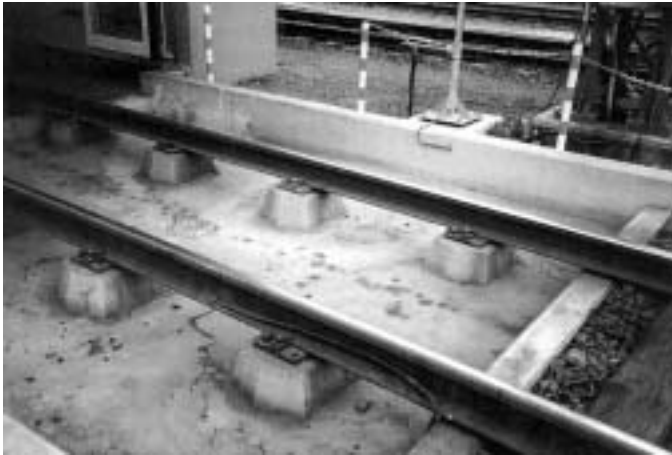
Bild 2: Spårinfästningar i betongtråg
