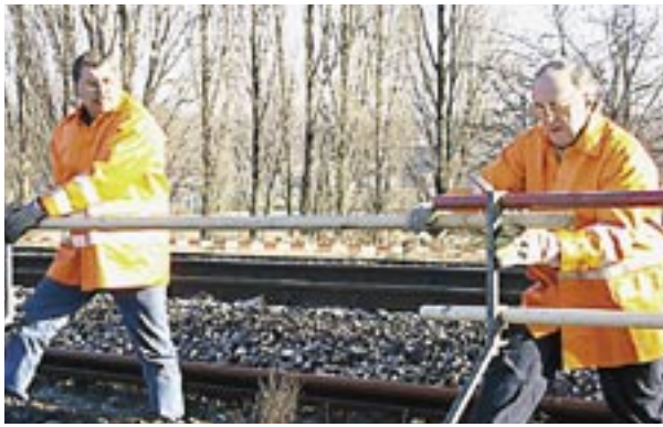
Två personer monterar de ultralätta 3 m långa glasfiberrören i växlande färgföljd ...
