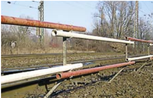
... så att den överskjutande delen är ungefär lika lång på bägge sidor (denna överlappningsteknik kompenserar monteringstoleranser).
