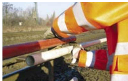
Rörmontering i "överlappningsteknik"
