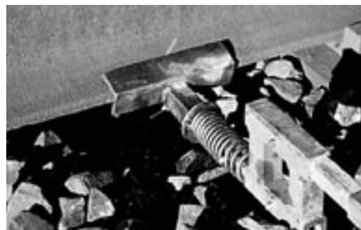
Avstånd mellan fästbyglarna: 2,50-2,70 m (normalt 4 slipers mellan fästbyglarna)
