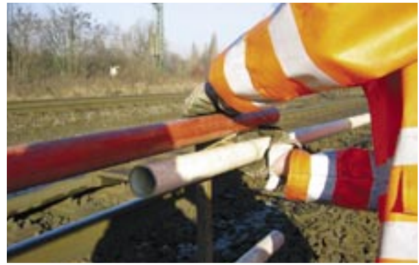
... genom att enkelt snäppa in rören i de standardiserade ISO-snabbklämmorna ...
