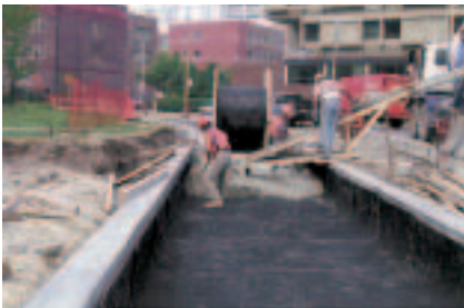
Clouth-USM® som "förlorad form" för ett massafjädringssystem (Toronto)
