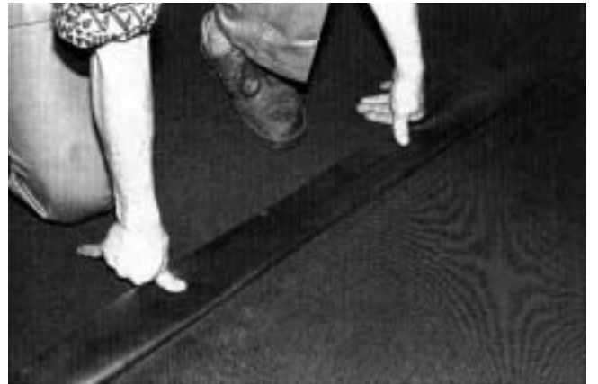
Fig. 8: Kontroll av fogar
