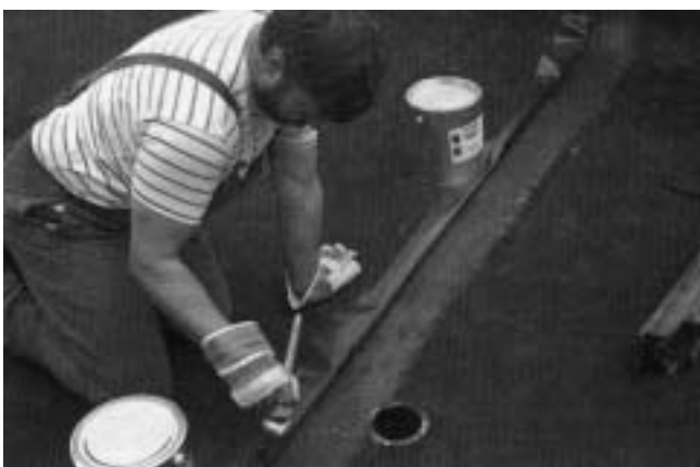
Fig. 14: Limning av överlappningsremsa
