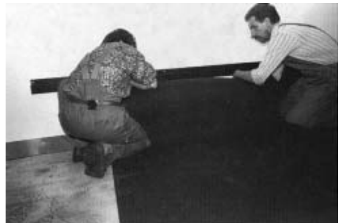
Fig. 20: Upphängning av mattor i ändprofilen
