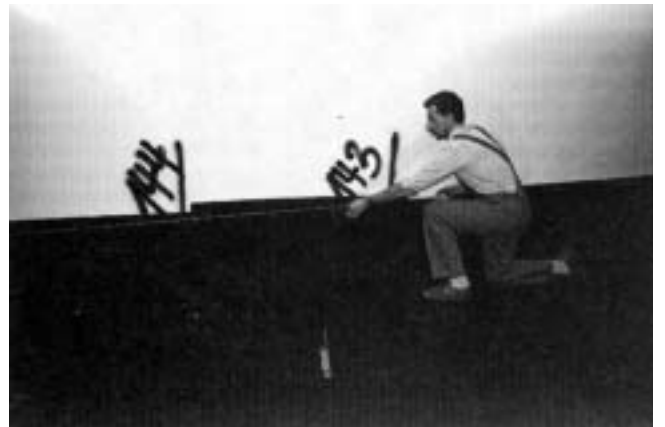
Fig. 9: Markering av kapningslinje med krita
