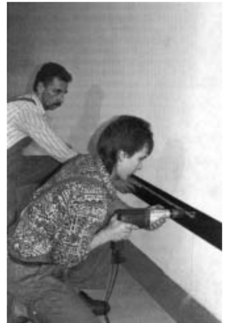
Fig. 19: Borring, hålavstånd cirka 750 mm till 1 000 mm.
