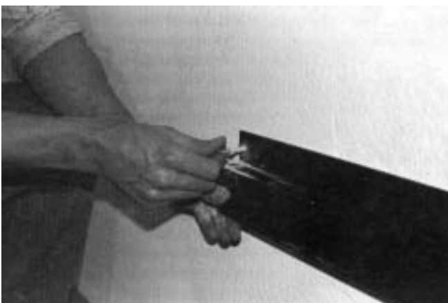
Fig. 17: Montering av tappar
