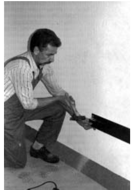
Fig. 18: Inslagning av tappar
