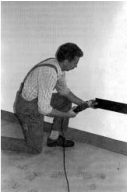
Fig. 16: Borring av tapphål
