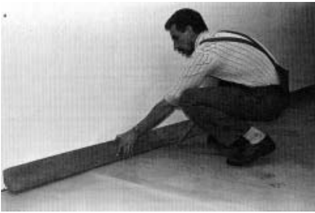
Fig. 4: Läggnig av hörnkil
