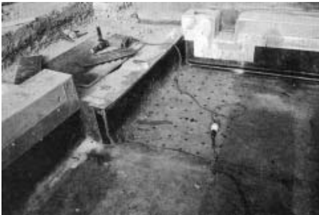
Fig. 23. Ballastmatta med dräneringshål
