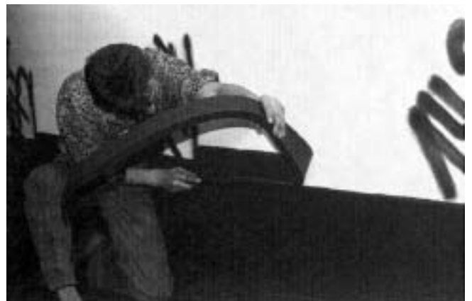
Fig. 10: Tillkapning av mattkanter
