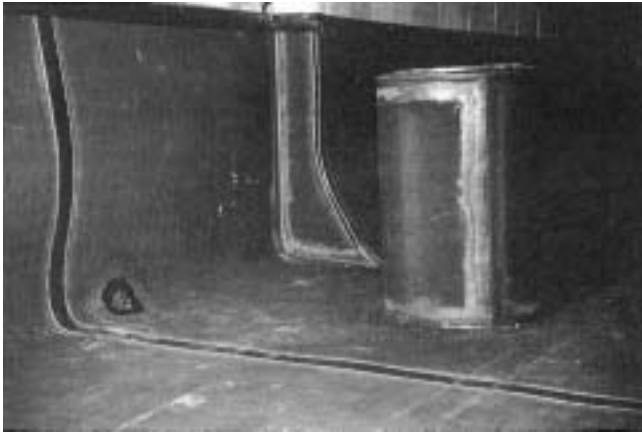
Fig. 22: Kanal, fodrad med ballastmattor; dräneringshål (till vänster)
