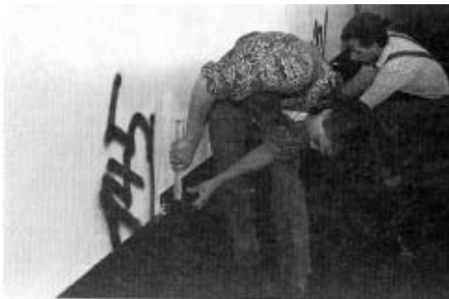
Fig. 13: Montering av tappar
